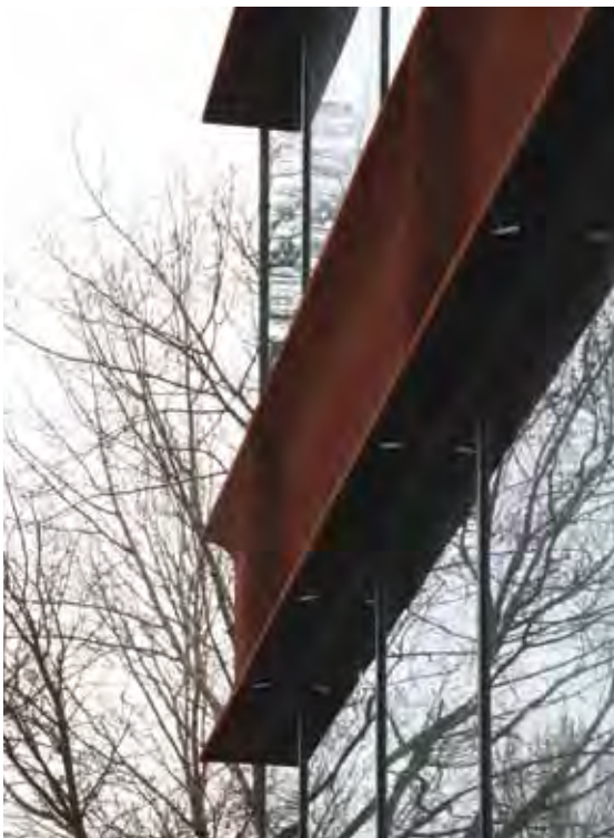
Stoere vormtaal beheerst ook het lichte atrium
