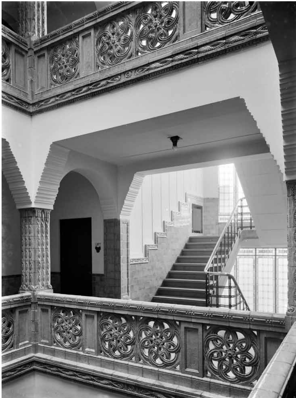
Trappenhuis en vide (foto: atelier Merkelbach)
