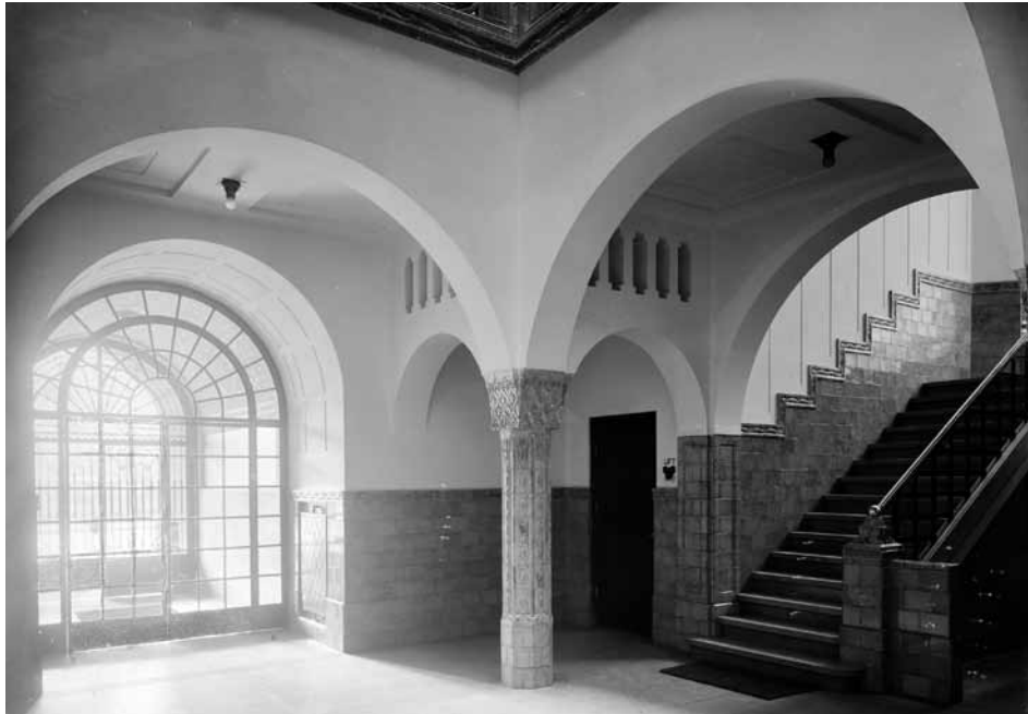
Entreeruimte met trappenhuis en vide (foto: atelier Merkelbach)
