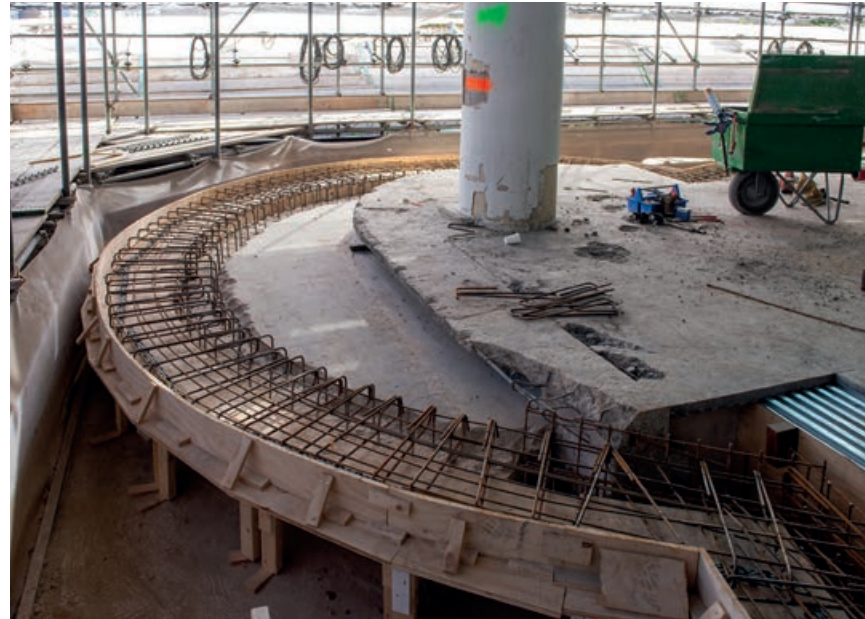
De vloerranden zijn hersteld volgens de originele lijnen, die bepaald zijn middels 3D-scans. (Foto: Maartje Brand / Brandbeeld)
