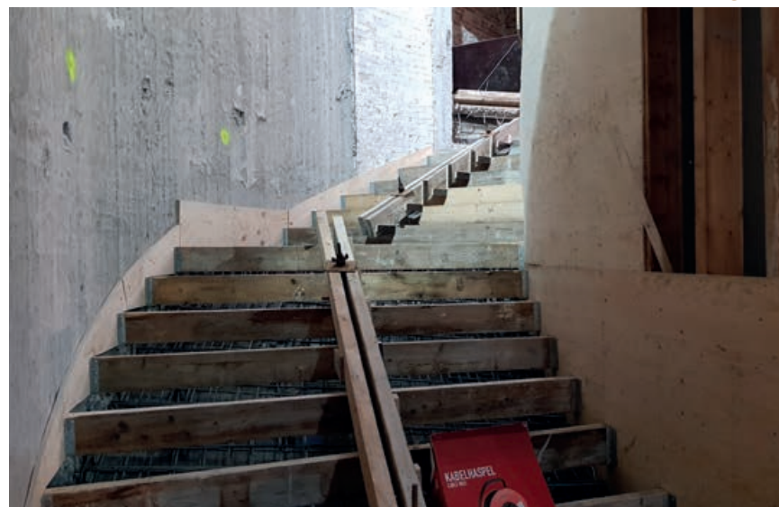
De rondlopende trappen zijn teruggebracht middels een in het werk uitgetimmerde bekisting.
