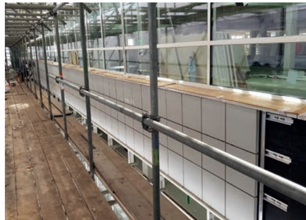
De vloerranden zijn hersteld volgens de originele lijnen, die bepaald zijn middels 3D-scans. (Foto: Maartje Brand / Brandbeeld)
