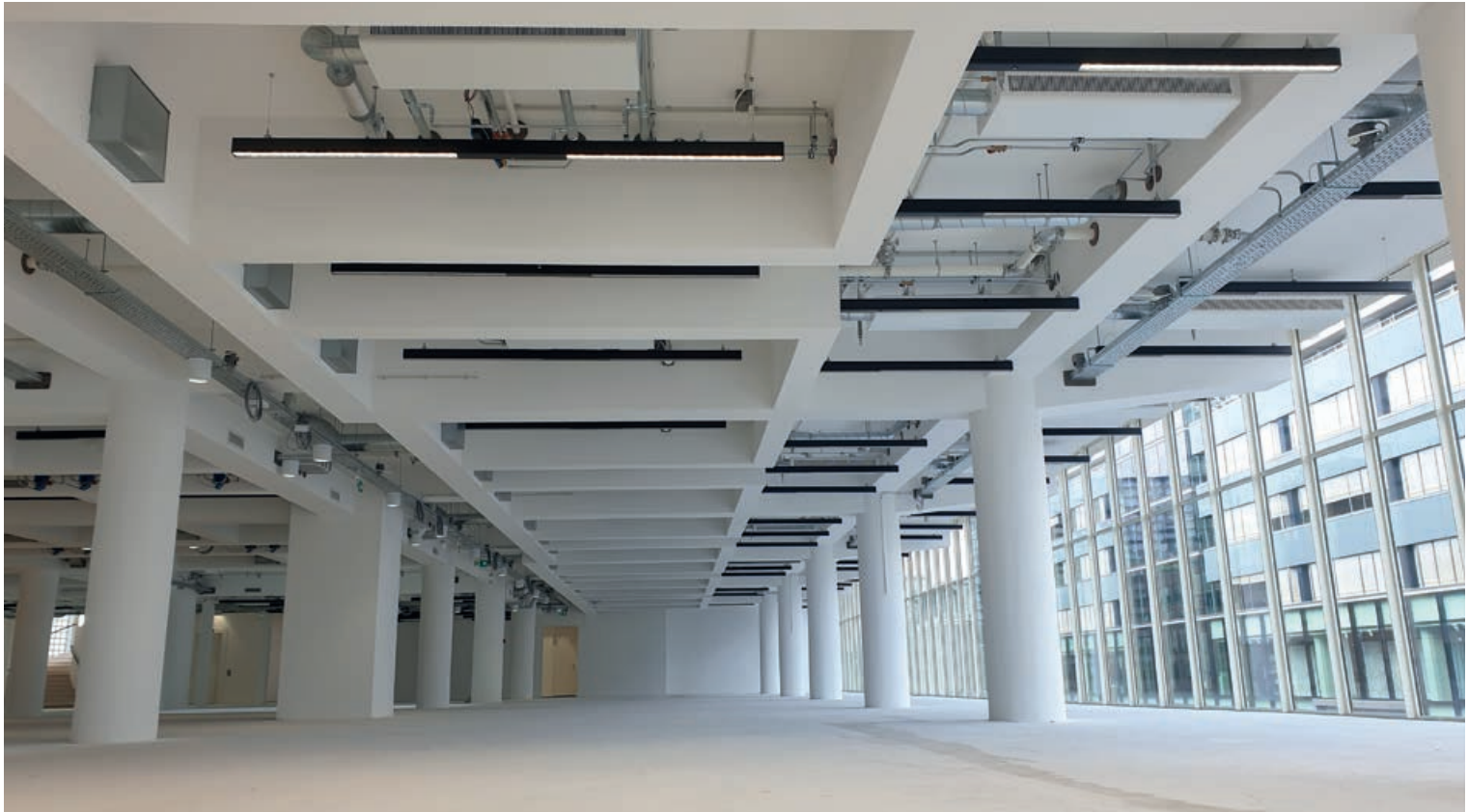
De betonnen balken zijn omtimmerd en verlaagd om er eenvoudig scheidingswanden onder te kunnen plaatsen.
