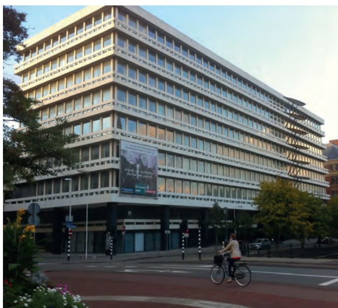
Het voormalige kantoor aan de Kortenaerkade met een horizontaal geaccentueerde gevel van witte betonelementen (foto: ZZDP Architecten).
