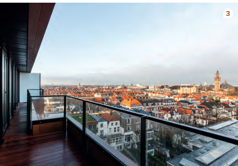
1 // Op het dak is een extra verdieping geplaatst die de bestaande dakopbouw met installaties vervangt. 2 // De balkons zijn opgebouwd uit een met EPDM afgewerkte staalplaatbetonvloer waarover onderslagbalken liggen met hardhouten terrasdelen (foto: Syntrus Achmea). 3 // De balkons hebben transparante balustrades van veiligheidsglas en een privacy scherm van ondoorzichtig glas (foto: Syntrus Achmea).
