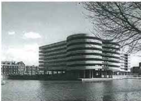
Omdat onder de parkeergarage aan de Marnixstraat in Amsterdam een ruimte voor bussen moest komen, is het gebouw op kolommen geplaatst.
