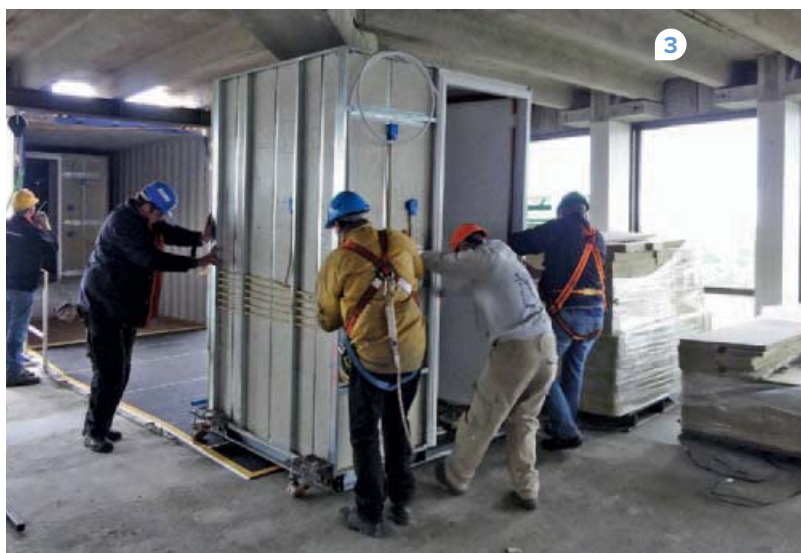
1 // Aansluiting van de nieuwe glazen pui op de gerenoveerde grindbetonnen gevel van de hoteltoren. 2 // De vloeren in de toren bestaan uit TT-liggers, die op L-vormige balken liggen. Tussen de T-balken zijn gipsplaten met minerale wol als geluidsisolatie aangebracht. 3 // Een prefab badkamer wordt vanuit de zeecontainer door een softspot in de gevel naar binnen gereden.
