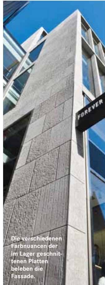
Durch die gewollten „Fehlstellen“ in der Rillenstruktur erhält die Natursteinfassade ihr gewünschtes „altes“ Aussehen.
