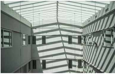
Het grote dakraam geeft licht in Clink Noord, met binnen een café, restaurant, bar, bioscoop en concertzaaltje. Maar geen buitenterras. Eva Plevier
